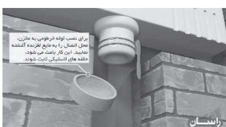
فلاش تانک را بصورت سر هم شده در جایی که در دیوار برش دادید قرار دهید و دهانه انتهایی لوله خرطومی به همراه تبدیل لاستیکی آن را در محل نصب توالت ایرانی (سوراخ پشت سوراخ توالت ایرانی) تعییه کنید.
