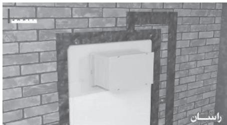
لازم به ذکر است که که باید درب کلید فلاش تانک را باز کنید و بعد از انجام این عملیات دوباره در جای خود بیندید و سپس کار کاشی کاری کف و دیوار باید انجام شود که باید نهایت دقیق صورت گیرد که به تراز بودن فلاش تانک آسیبی وارد نشود.
