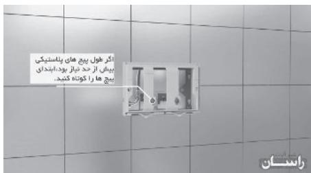
جهت نصب کلید فلاش تانک ابتدا پیچ ها را به اندازه نیاز کوتاه کنید.
